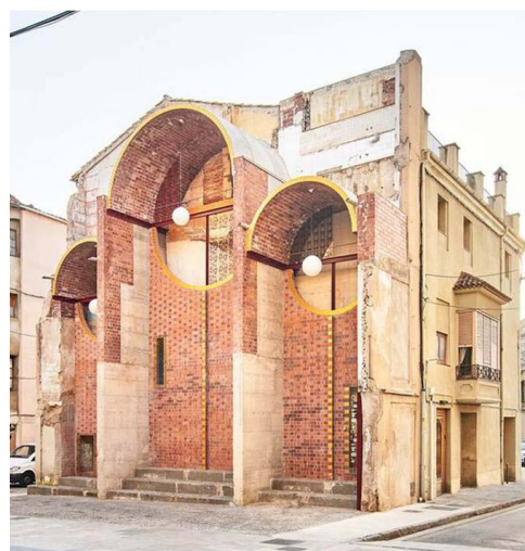
Figura 7. Escenografía de Urgencia. Estado previo (Guidetti y Robiglio 2021: 8). Estado actual. Fotógrafo: José Hevia (ref. web 1).
